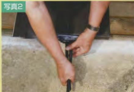
掴み込んだ板が同じ幅になるようにし、前方に巻き込む。
